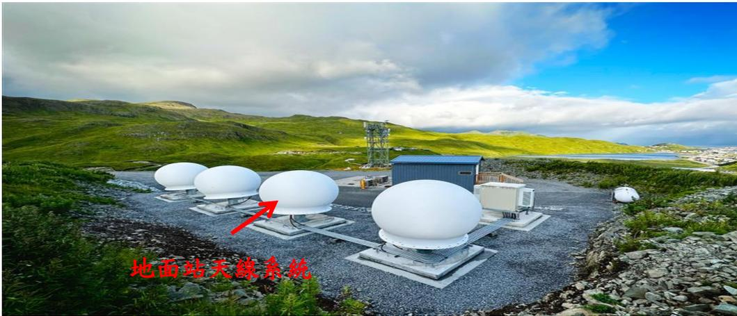
地面站Gateway天線系統的數量與衛星的傳輸頻寬需求及速度呈正相關，一般來說Gateway天線的數量會比衛星數更多以保持寬頻通訊的品質
